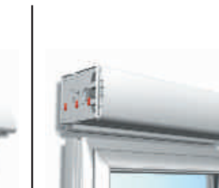
11 Mise en place du caisson sur la traverse haute.
